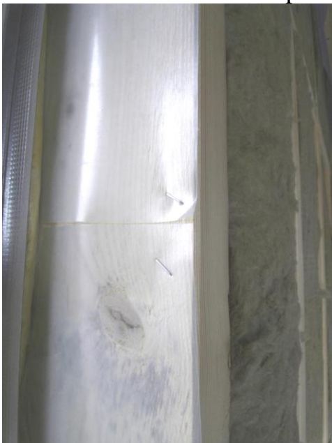
Figur 1 Ej överlappad skarv av plastfolie i fönstersmyg
