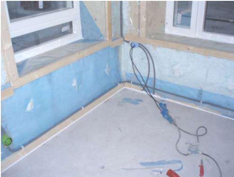
Figur 64 Hål för sprutning av lösull (Wahlgren, 2010)
