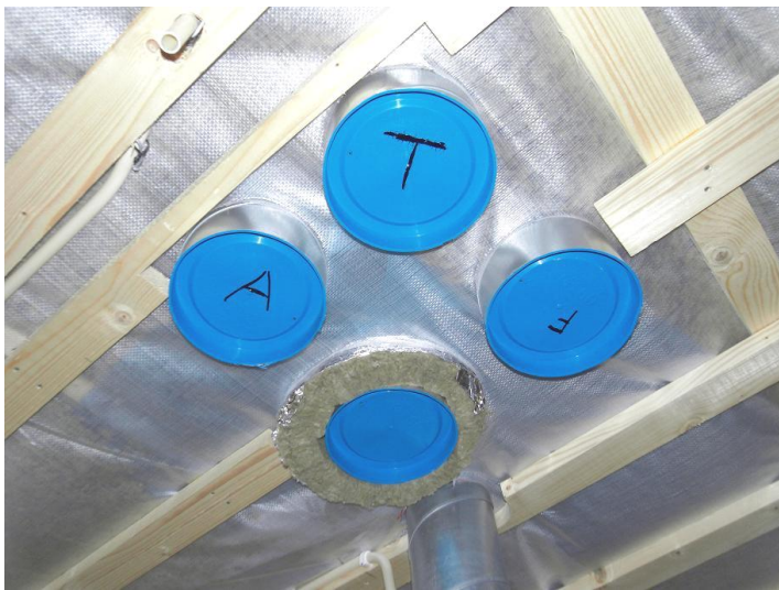
Figur 2 Venötilationsrör genom plastfolie i vindsbjälklag
