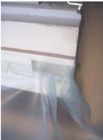
Figur 10 Veckat plastfoliehorn fäst med dubbelhäftande tejp (Wahlgren, 2010)
