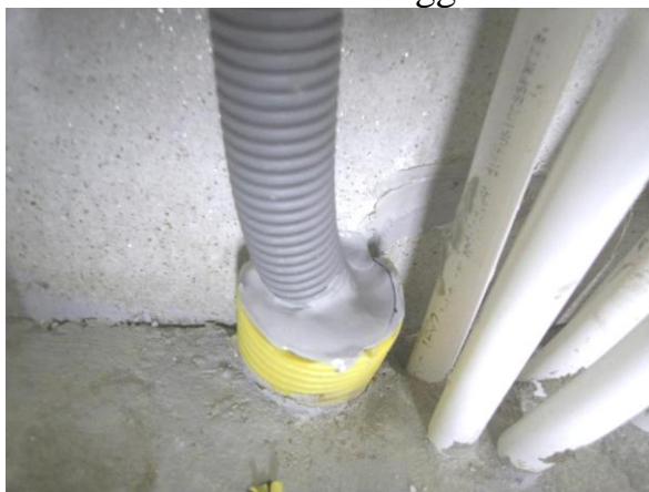
Figur 7 Fog mellan yttre och inre rör
