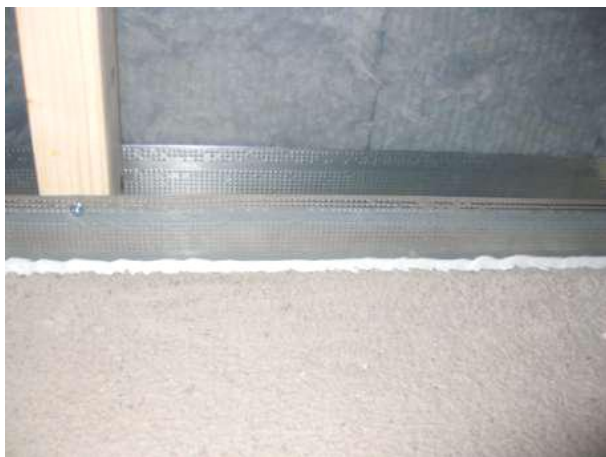
Figur 15 Plåtregel med plastfolie fogad mot betong (Wahlgren, 2010).
