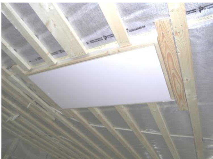
Figur 28 Vindslucka monterad i vindsbjälklag (Platsbesök)
