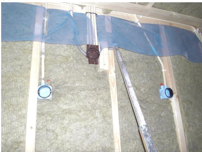
Figur 3 Slarvigt uppskuren plast vid mellanbjälklag
